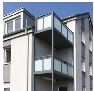
Neubau Mehrfamilienhaus Bedburg-Hau, Alte Bahn, 3 mehrgeschossige Balkonanlagen
