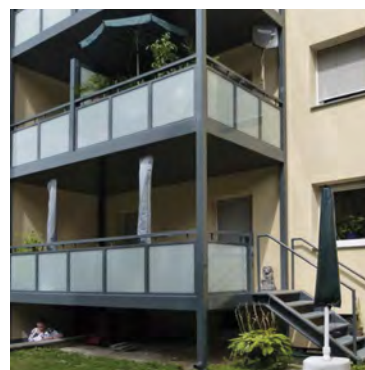
Sanierung Mehrfamilienhaus, 2 dreigeschossige Balkonanlagen, Mönchengladbach
