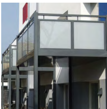
Neubau Mehrfamilienhaus Kleve, Königsgarten, 4 eingeschossige Balkonanlagen
