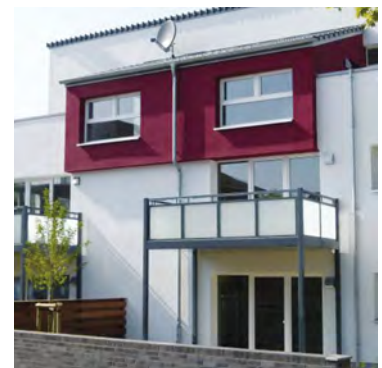
Neubau Mehrfamilienhaus Kleve, Weberstr., 2 eingeschossige Balkonanlagen
